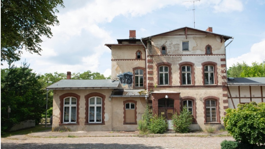
Abb.: Bahnhof Lindow (Mark) Hauptgebäude von Bahnhofstraße aus (2020)
